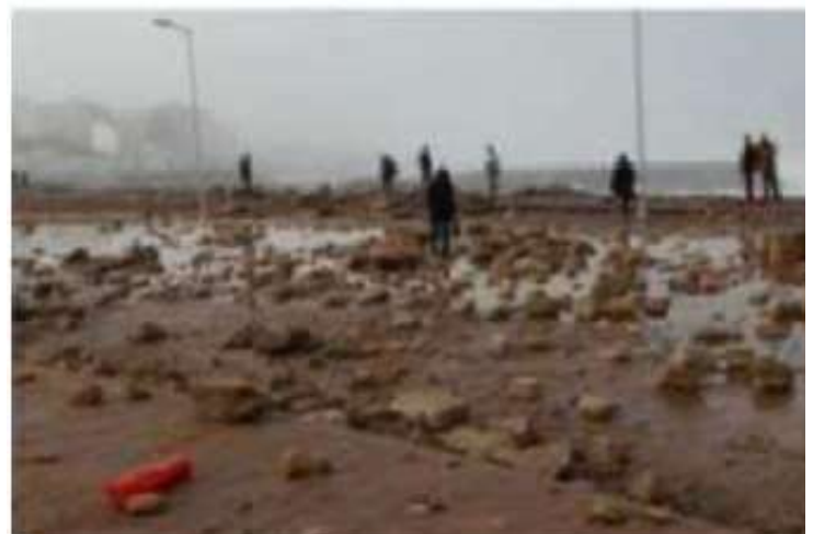
Photo 12 : Dégâts causés à la Côte de Salé en Février 2017
