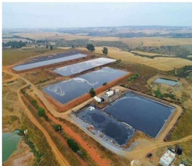
Photo 15 : Bassins de stockage de Lixiviat
